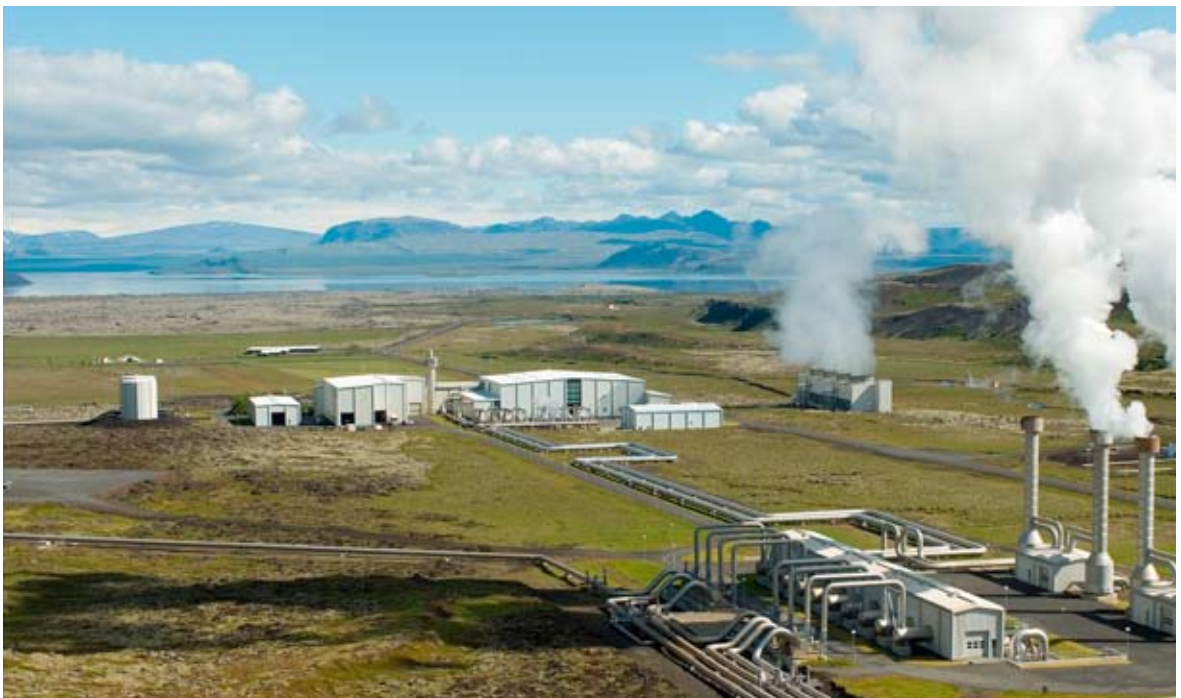
Nesjavellir Power Plant.
